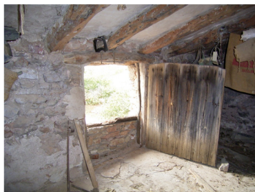
②マジアの二階部分。屋根下地がそのまま天井となっている
