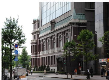
⑦ファサード保存の例(東京銀行協会ビルディング)
