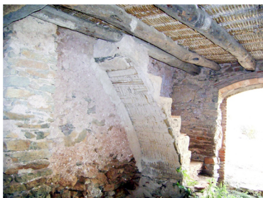
①マジア内部の床と階段。葦のような植物の茎を編んだものに土と切開を塗り付けている
