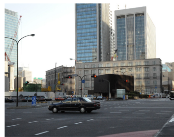
⑥工事中の旧東京中央郵便局
