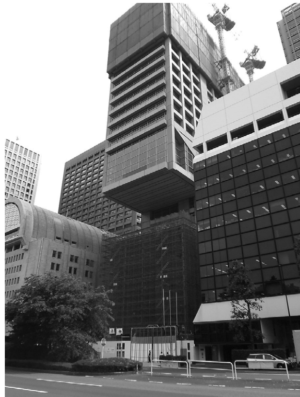
解体される旧長銀本店ビル
